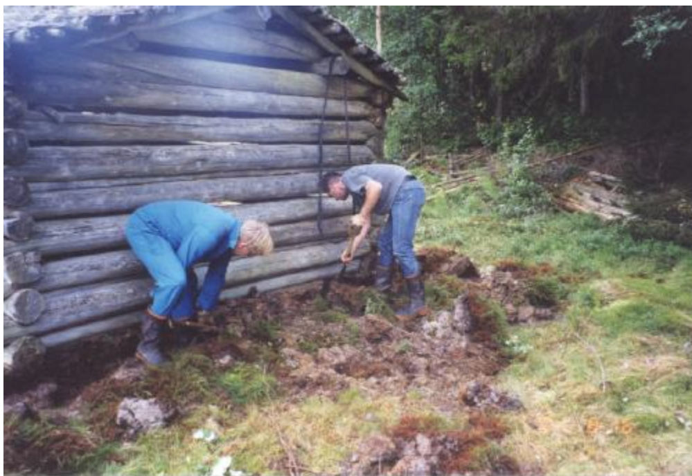
En åtgärd som är enkel att utföra är att gräva rent kring grunden. Björsjöbodarna, Haverö (Harry Walker, 2001)
